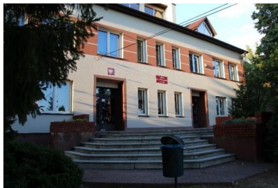
Fot. nr 61, Publiczna Szkoła Podstawowa w Sokole
