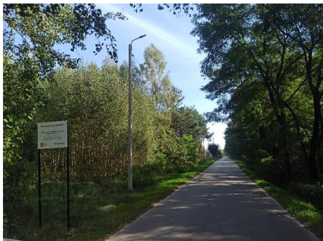
Fot. nr 48, Modernizacja drogi w Kaleniu Drugim
