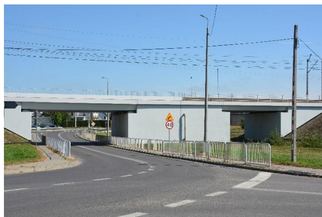
Fot. nr 47, Wiadukt kolejowy w Sobolewie
