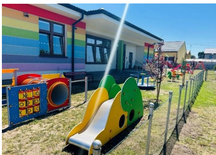
Fot. nr 69, Publiczny Żłobek w Sobolewie
