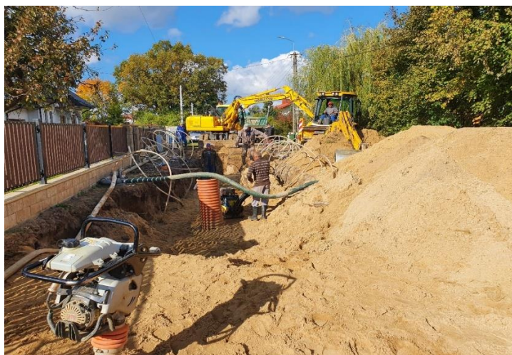
Fot. nr 37, Budowa kanalizacji Sobolew, ul. Leszcynowa
