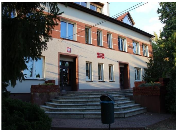
Fot. nr 70, Publiczna Szkoła Podstawowa w Sokole
