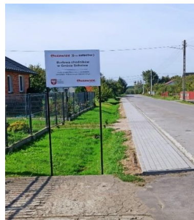
Fot. nr 53, Budowa chodnika w Trzciance
