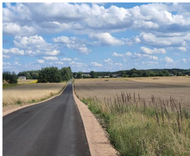
Fot. nr 49, Modernizacja drogi w Kownacicy
