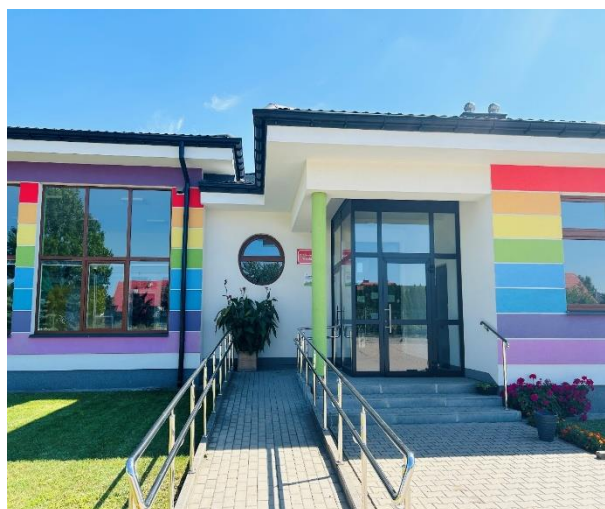
Fot. nr 67, Publiczny Żłobek w Sobolewie
