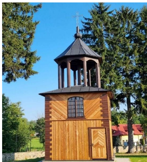
Fot. nr 16, Odrestaurowana dzwonnica na cmentarzu parafialnym w Gończycach
