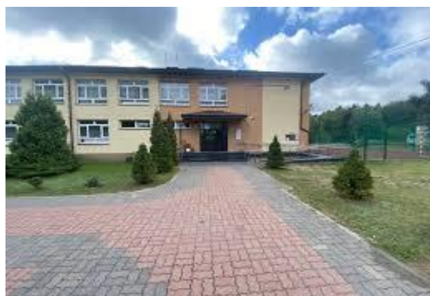
Fot. nr 78, Budynek Ośrodka Szkolno-Wychowawczego w Przyłęku
