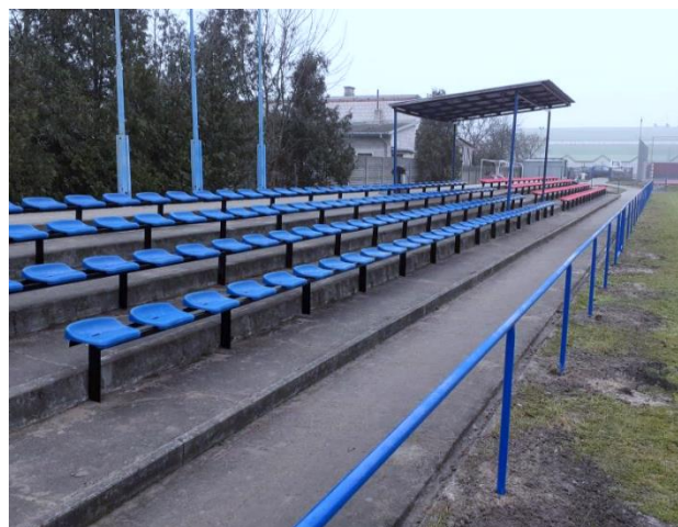
Fot. nr 84, Trybuny na stadionie w Sobolewie
