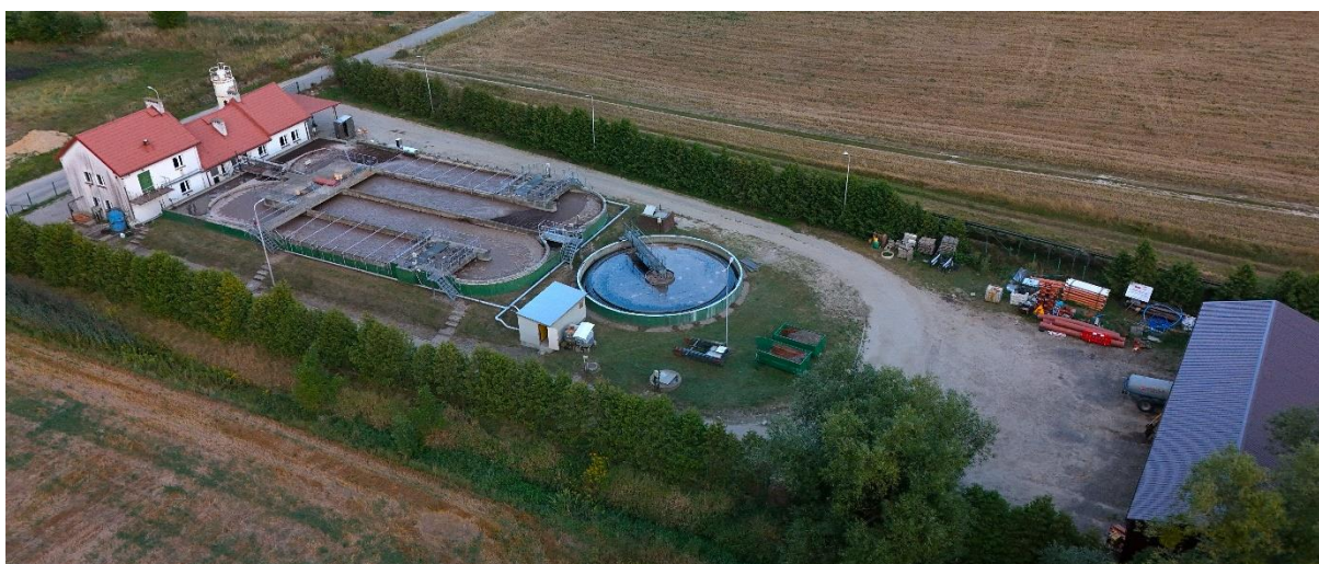
Fot. nr 41, Oczyszczalnia ścieków w Sobolewie
