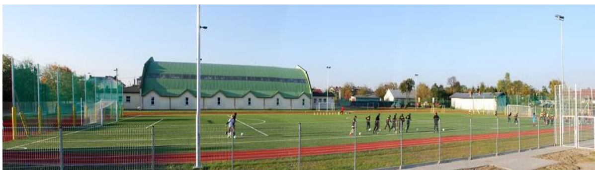
Fot. nr 64, Hala sportowa wraz z boiskiem w Sobolewie
