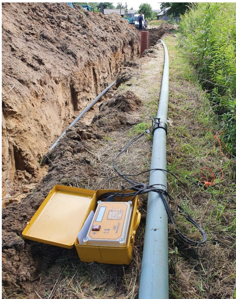
Fot. nr 38, Budowa kanalizacji Sobolew, ul. Piaskowa
