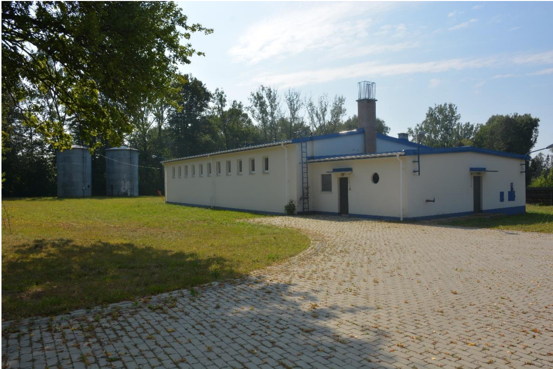
Fot. nr 34, SUW Gończyce (po modernizacji w 2022 roku)
