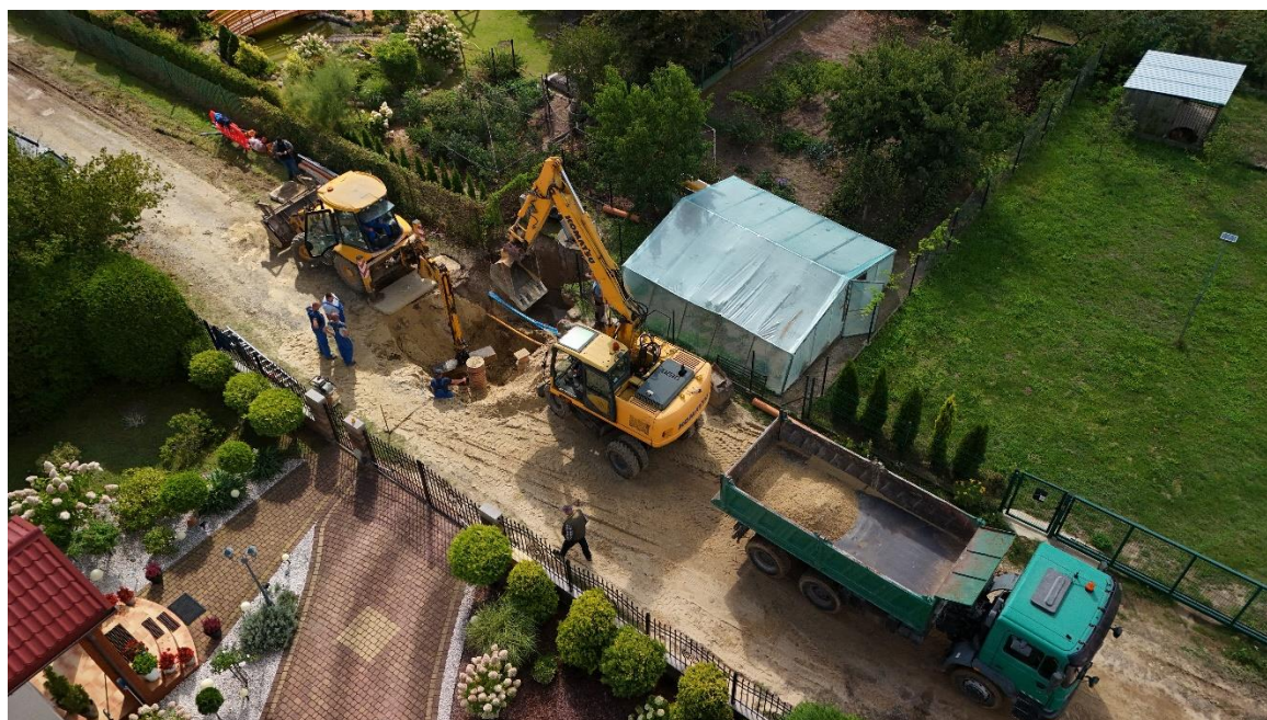
Fot. nr 39, Budowa kanalizacji sanitarnej, Sobolew, ul. Liliowa 2025
